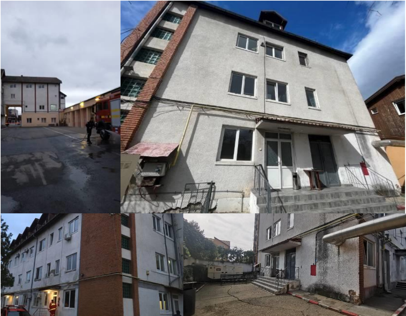
Figura 7 Clădirea administrativă C1 a ISUJ SIBIU și DPS
